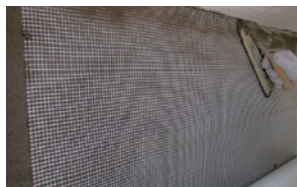
②HSスーパーネット伏せ込み
