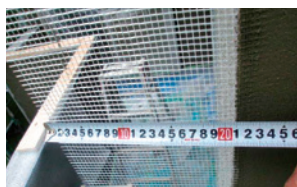
(出隅部)回し張りは200mm以上 継ぎ目は縦横50mm以上
