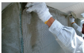
(出隅部)突き付け張り。コーナーから 概ね5mm以内
