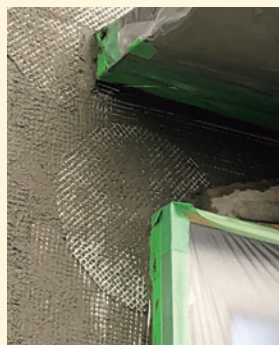
扉と窓の間にも簡単に作業できる
