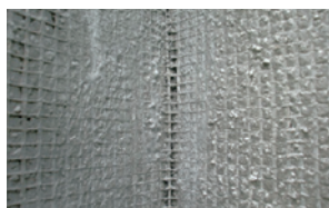
入隅部は200mm以上回し張り
